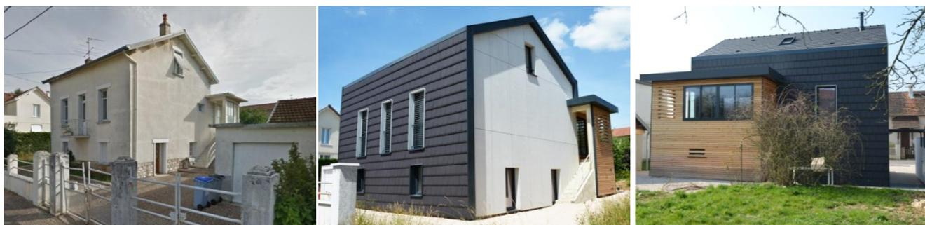
Pour respecter la réglementation thermique (RT2012), l'architecte retient la solution des tuiles en terre cuite pour une Isolation Thermique par l'Extérieur, permettant d'isoler avec un seul matériau trois des cinq façades. Autre intérêt, la tuile terre cuite entre dans le cahier des charges à côté de matériaux bio sourcés.
