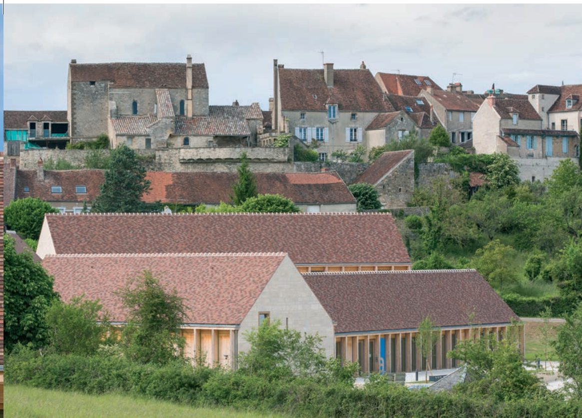
▲ Vue générale depuis le Sud-Ouest.
