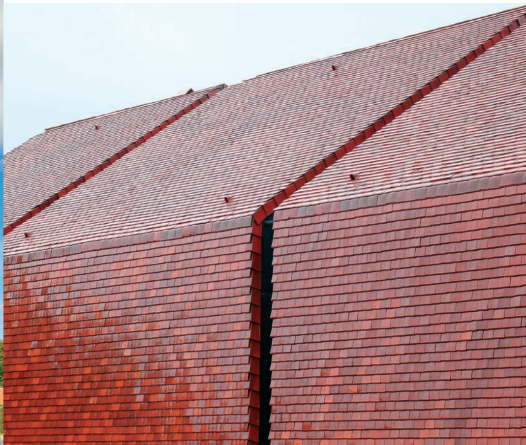
▲ Les détails de rive, de faîtage et de membron a nécessité la réalisation de pièces sur mesure.
