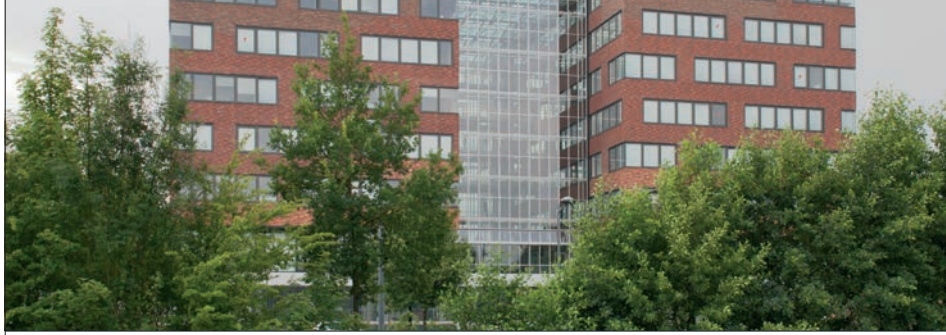
▲ Vue depuis l'autre rive du canal de Roubaix.
