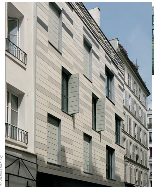
▲ Vue de la rue Volta.
