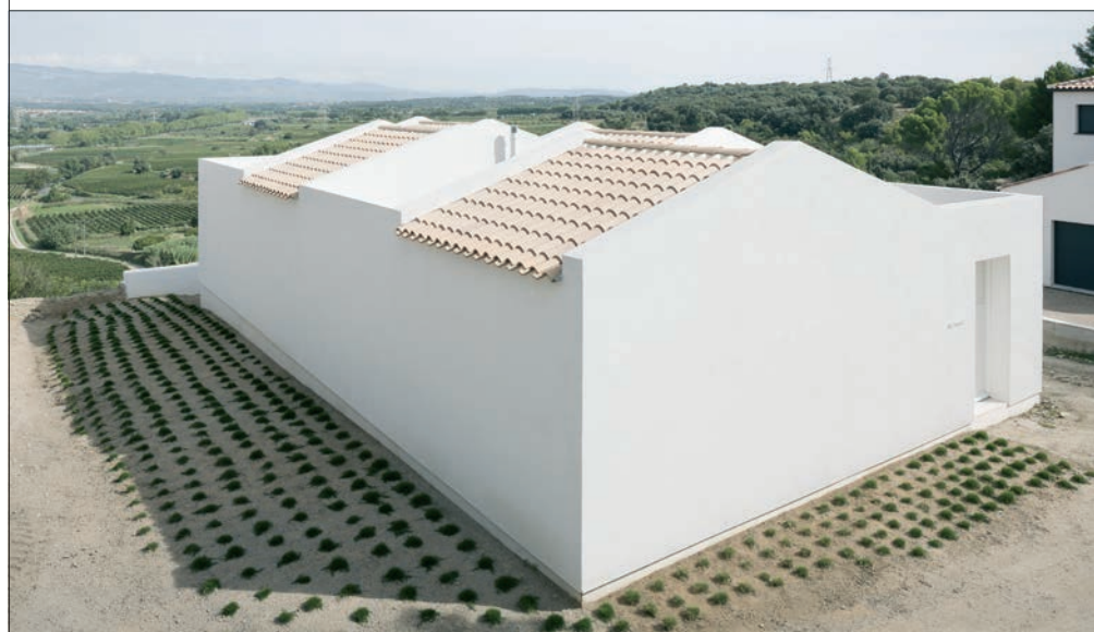
▲ Sans fenêtre sur ses voisins, la maison est entièrement tournée vers le paysage.
