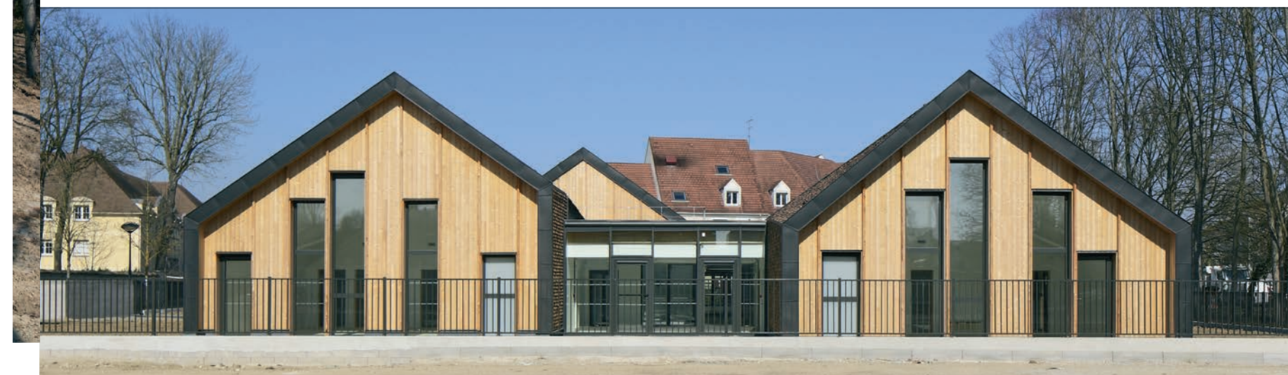
▲ Vue de la façade sud. Les apports lumineux sont gérés par un dispositif de stores extérieurs en réseau sur toutes les surfaces vitrées du bâtiment.
