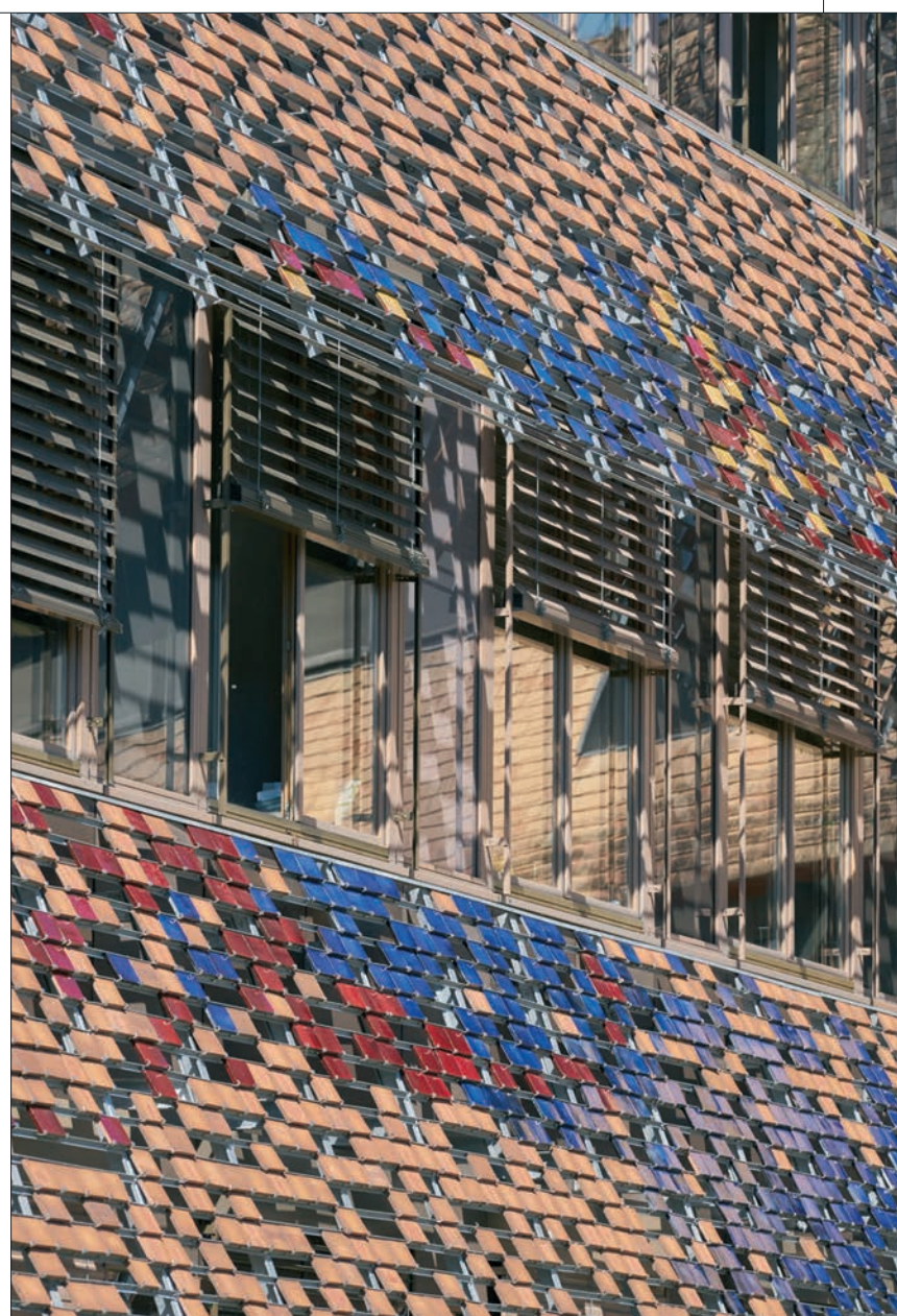
▲ Détail façade terre cuite.
