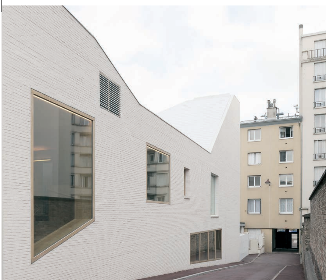
▲ Vue depuis la venelle : relations visuelles à travers les grandes fenêtres de bois entre l'espace public et les circulations intérieures du conservatoire.
