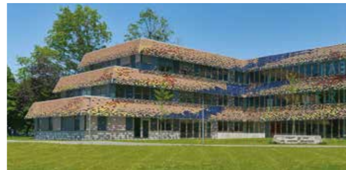
Extension et restructuration de locaux de recherche l'Université de Pau, Patrick Mauger architecte (2 e Prix de la catégorie Équipement/Tertiaire du palmarès 2016).
